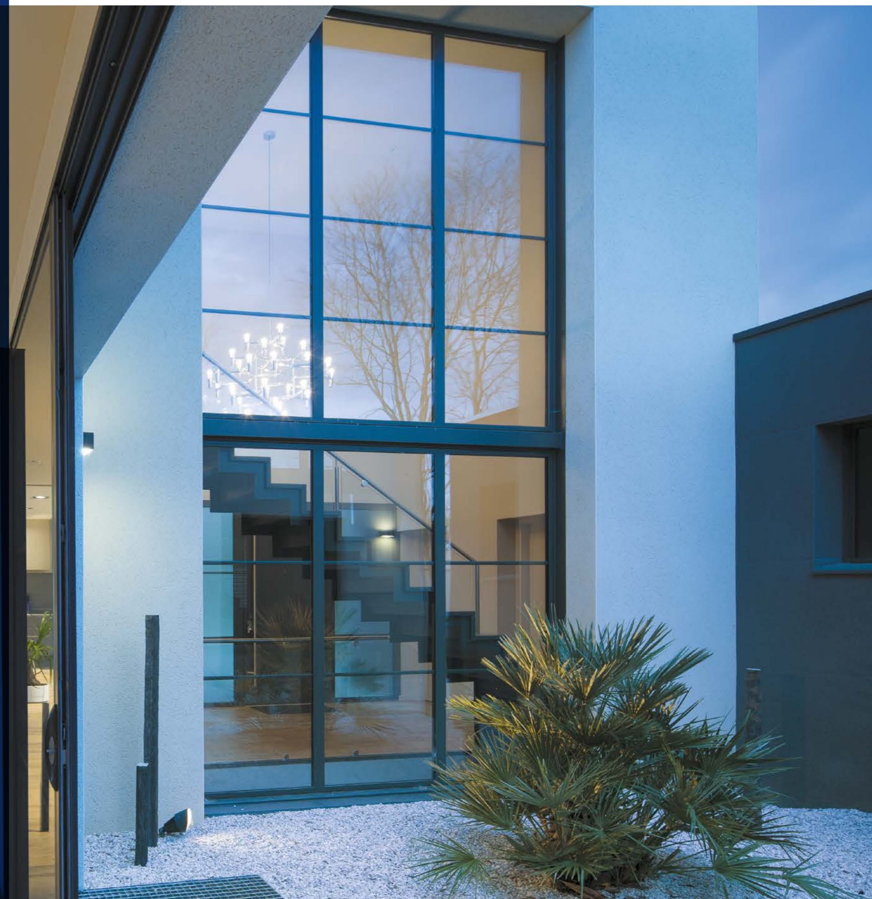
Daniel Morice, Architecte D.P.L.G. Ensemble composé avec petits bois intégrés dans le double vitrage.
